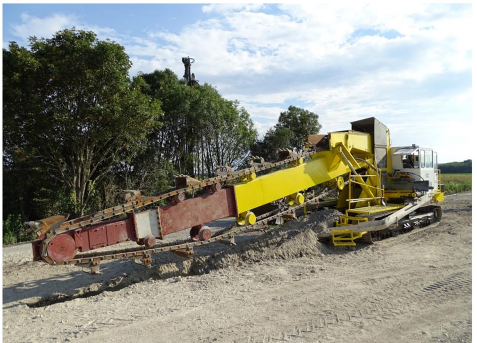
Auch im Baulos am Rußbach kommt neuerdings eine Dichtwandfräse zum Einsatz. © viadonau
